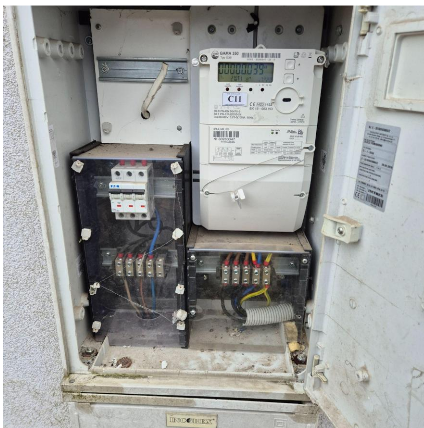
Rysunek 3.5 Złącze licznikowe
