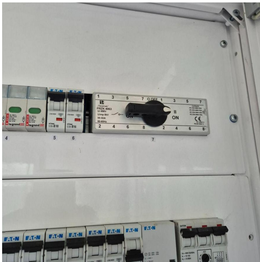
Rysunek 3.7 Przetwornik agregat - sieć w rozdzielnic głównej
