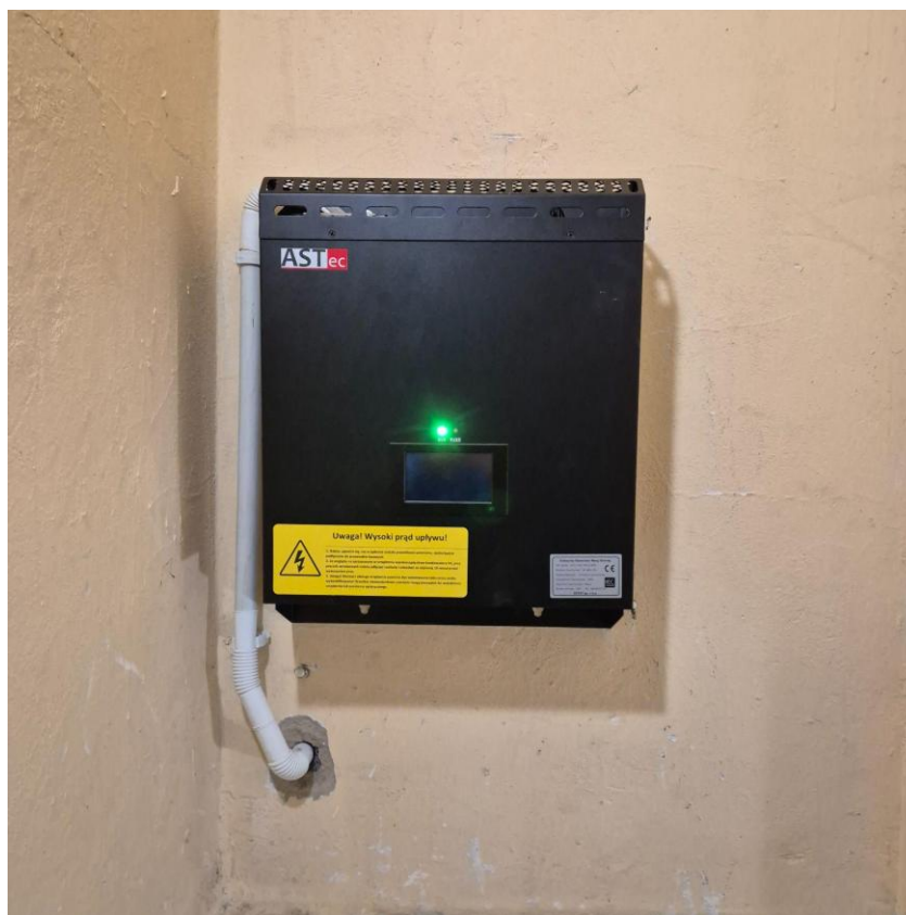
Rysunek 3.8 Kompensator mocy biernej
